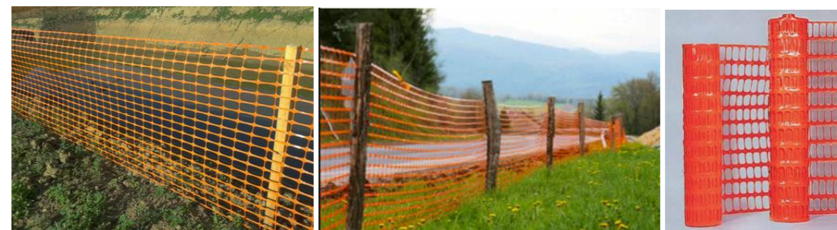
Exemple de balisage à mettre en place en périphérie du site
